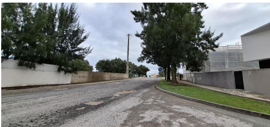
Fotos 83 a 85: Constrangimentos à circulação pedonal através de ausência de passeios ou à sua obstrução, assim como ausência de passadeira de peões em áreas residenciais importantes
