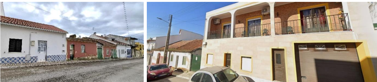
Fotos 97 e 98: Edifícios reabilitados com descaracterização arquitetónica com utilização de materiais diversificados em conjunto com edifícios em necessidade de reabilitação
