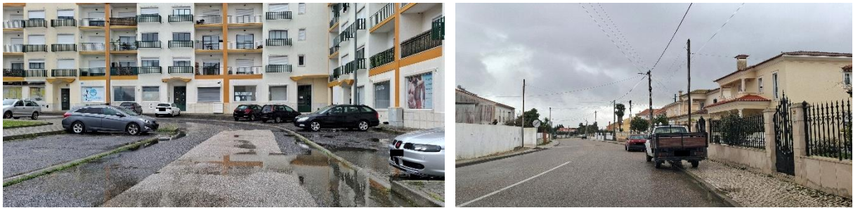
Fotos 130 a 133: Estacionamento desordenado ou com ausência de demarcação
