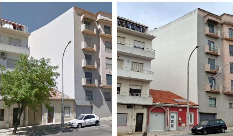
Fotos 96: (Google Street View 2014) e 97: Reabilitação de edifício unifamiliar - Avenida Mestre Cid
