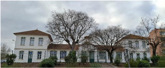
Fotos 47 e 48: Antiga Escola do Centro e Pavilhão do INATEL
