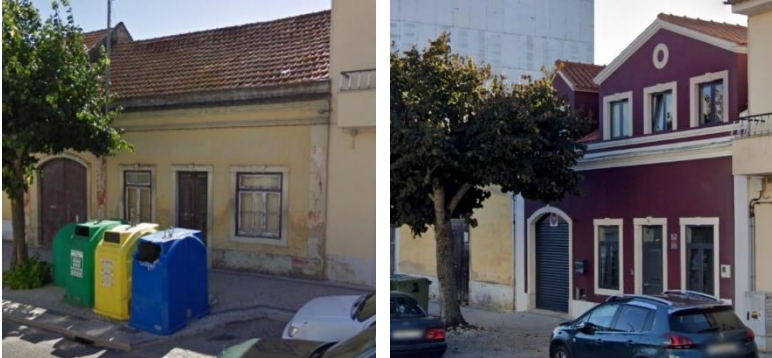
Fotos 94: (Google Street View 2009) e 95: Reabilitação de edifício unifamiliar - Avenida João de Deus
