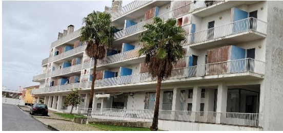
Fotos 123 e 124: Edifícios na Travessa do Progresso e Rua Serpa Pinto
