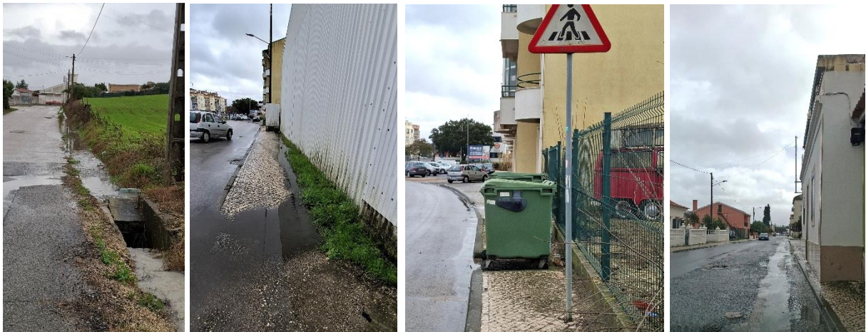
Fotos 134 a 137: Ausência de passeio ou com dimensão inapropriada
