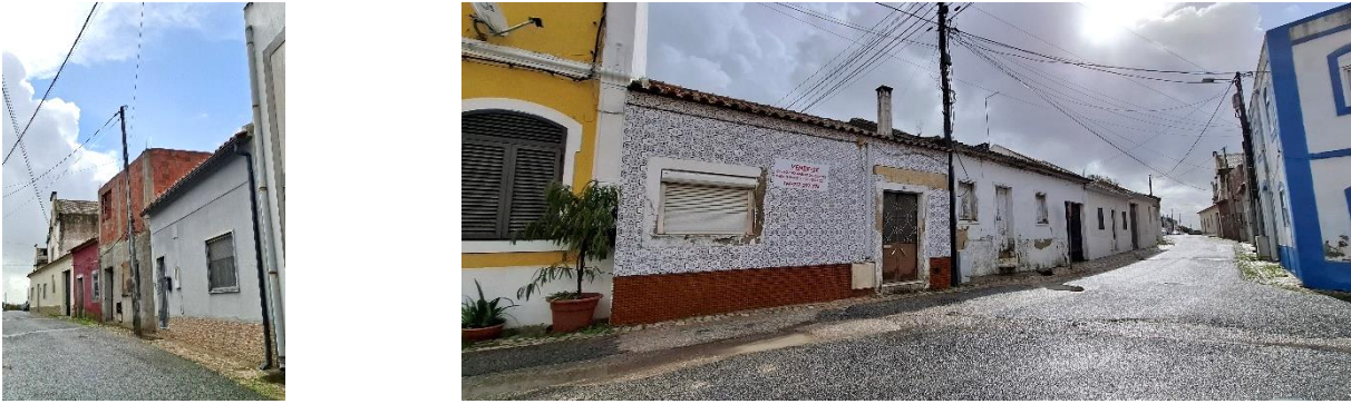
Fotos 41 e 42: Edifícios em necessidade de reabilitação com descaracterização arquitetónica e utilização de materiais diversificados
