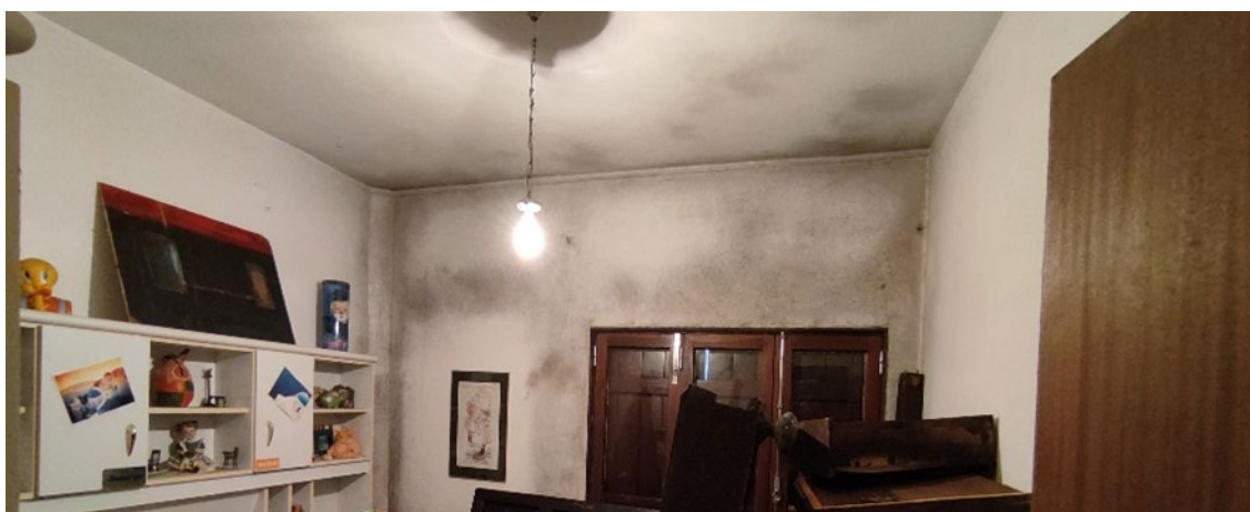
Habitação na avenida Egas Moniz, nº40, Valada – antes de intervenção
