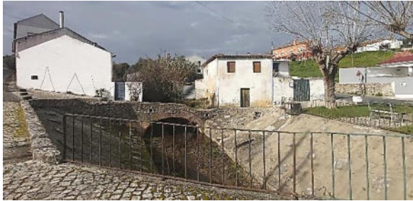
Fotos 13: Ponte Medieval
