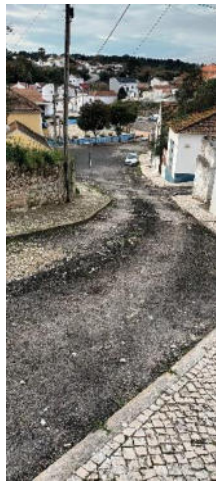
Fotos 59 a 61: Pavimentação inexistente ou em mau estado de conservação - Travessa dos Olivais - Rua da Fonte e Rua Valadim
