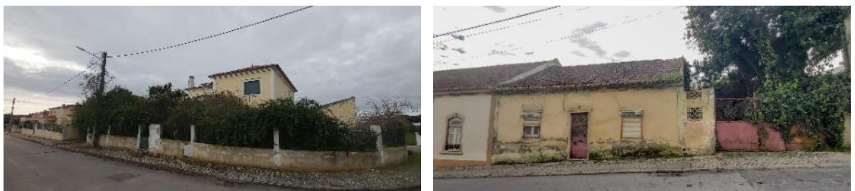
Fotos 36 a 37: Edifícios devolutos com necessidade de intervenção
