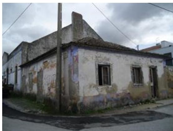
Figura 2 - Edifício devoluto na Rua da Boa Vista
