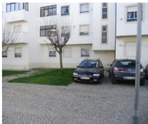
Figura 7 – Urbanização do Quintalão com veículos estacionados na área pedonal, falta de estacionamento
